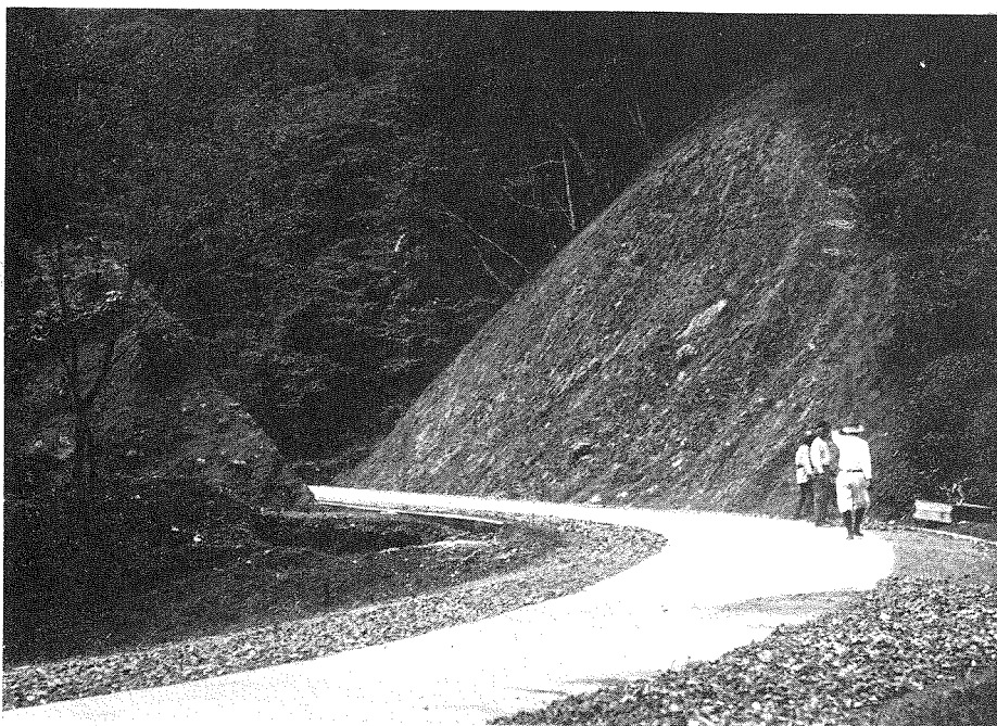
写真 8. 測点 10.500 米 附近 コンクリート舗装。
