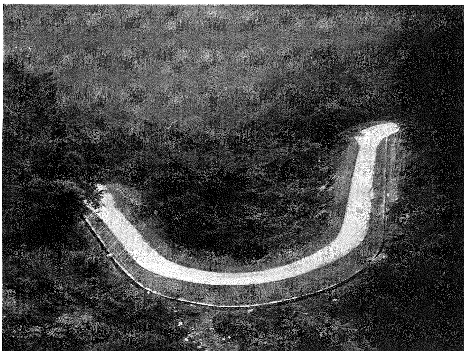
写真 7. 測点 5200 米附近コンクリート舗装。
