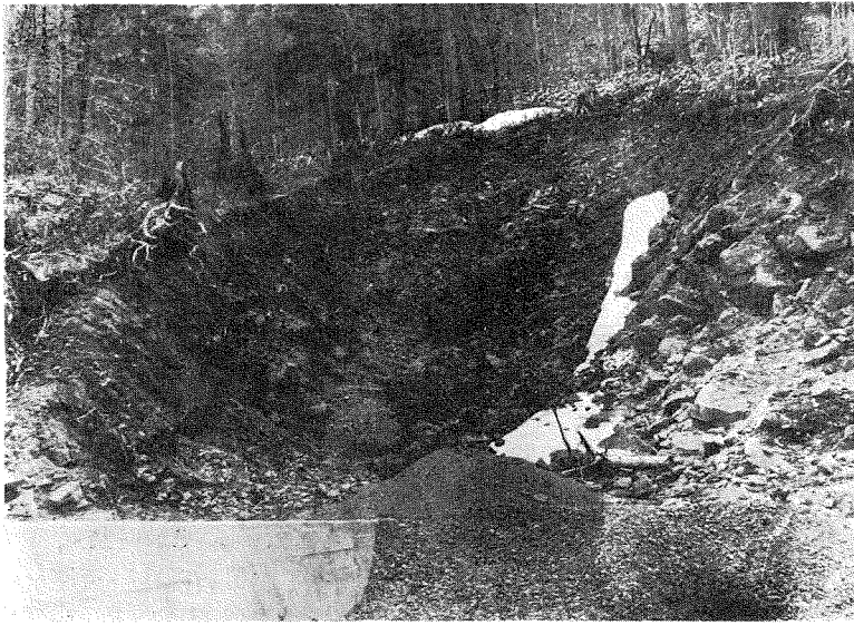
寫眞 3、堰堤南端附根地盤切取箇所の裂罅
