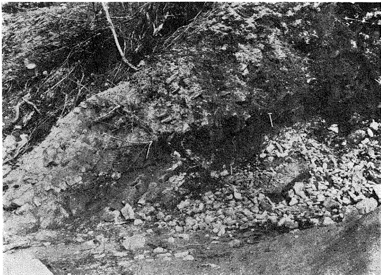
寫眞 4、堰堤南地盤切取箇處の著しき裂罅。
