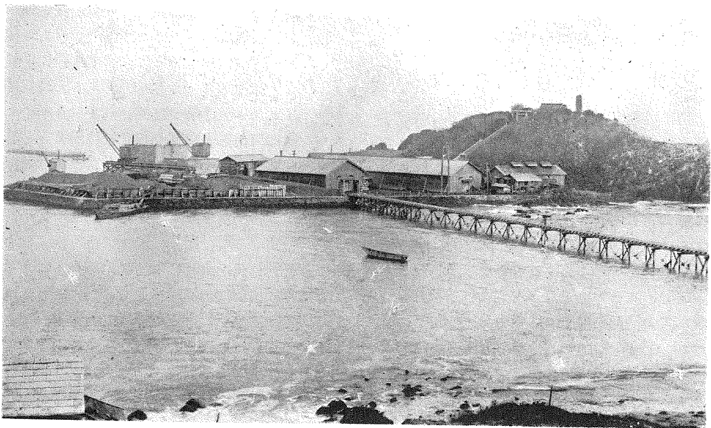
(2) 假 棧 橋 及 工 場 全 景。
