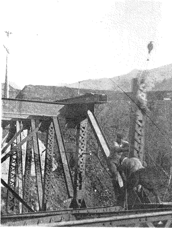
4. 床桁取付作業。↓
