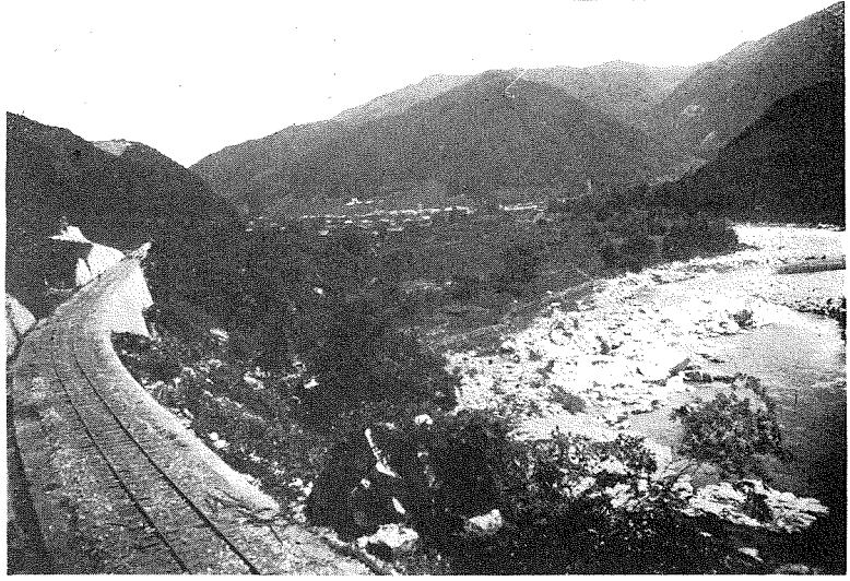
(9) 109 杆附近より見たる小坂町の遠景でこの附近は急峻なる山腹を 匍ひ益田川の断崖に沿ふを以て幾多の土留擁壁を施工したり
