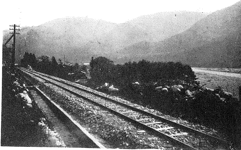
(1) 工區始點98杆 4 附近より振り返って 萩原町及益田川を望む 右側線路下が縣道なり
