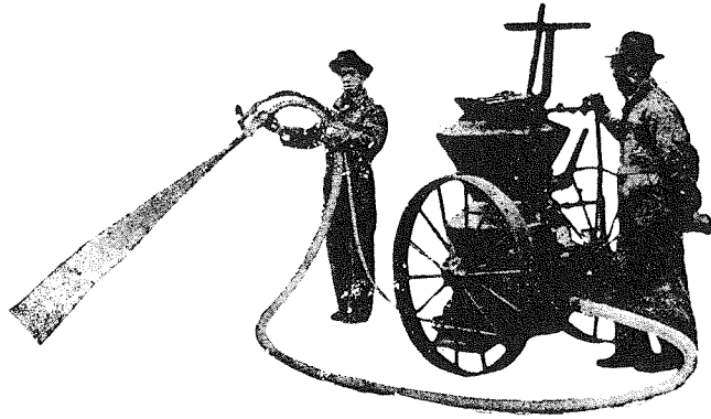
ガンクリート運轉中の光景
