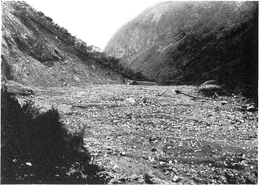
2. 堰堤築造後上流より下流に向つて堆積土砂の状況を寫したもので、其貯砂量 7萬餘立方米に達してゐる。堰堤の高さは16米、長さ63米である。
