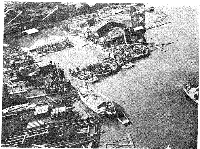
(4) 佐賀線筑後 橋梁工事 満潮時にドックか、井筒を曳 出す。井筒はそれ自體が浮揚 する。兩側の舢舨は補助であ る。
