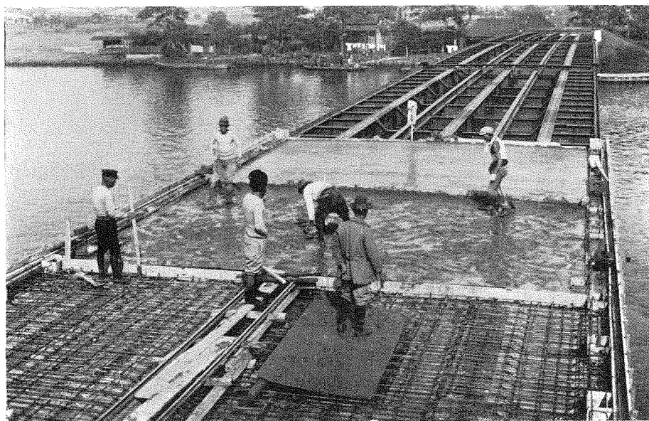
(9) 床版コンクリート工事中の光景。
