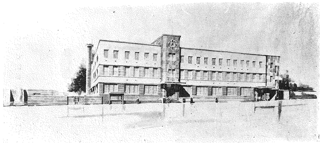
(6) 東京市四谷區役所(工事中)
