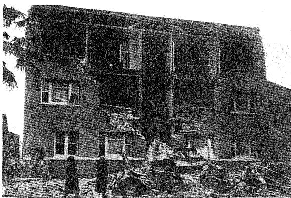
写真5 ロングビーチ市の一教會堂の隔壁が破壊された有様で、勿論耐震的な構造ではなかつた。
