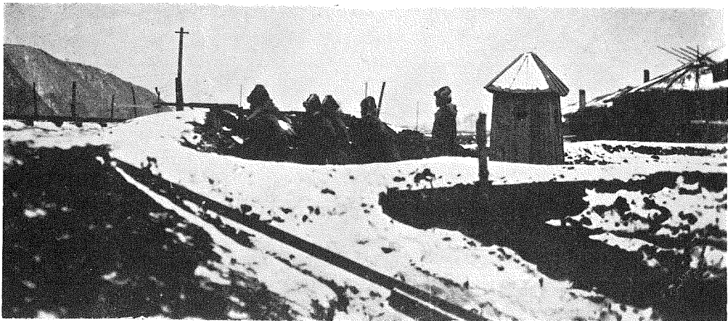
(4) 老頭溝附近敷設工事守備中の皇軍
