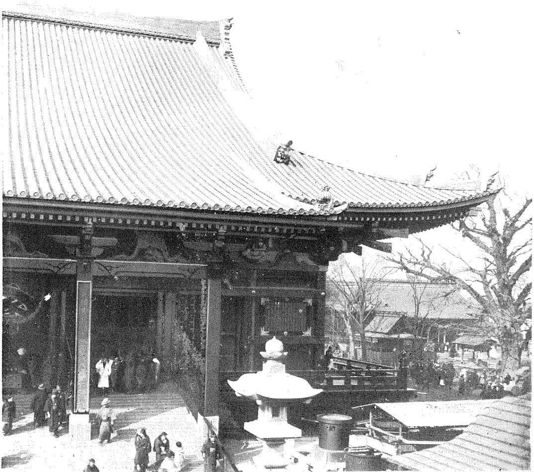
(3) 草 寺 観 音 堂 正 面 東 部。
