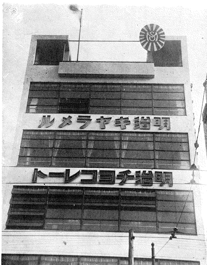
(1) 正面三階から上の外観。
