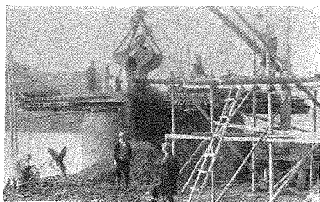
↑ (3) 井筒沈下作業の實況。
