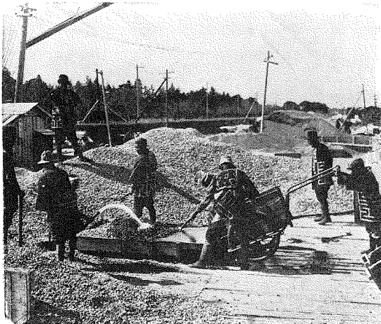
寫眞——濾床集水層材料洗滌狀況……………
