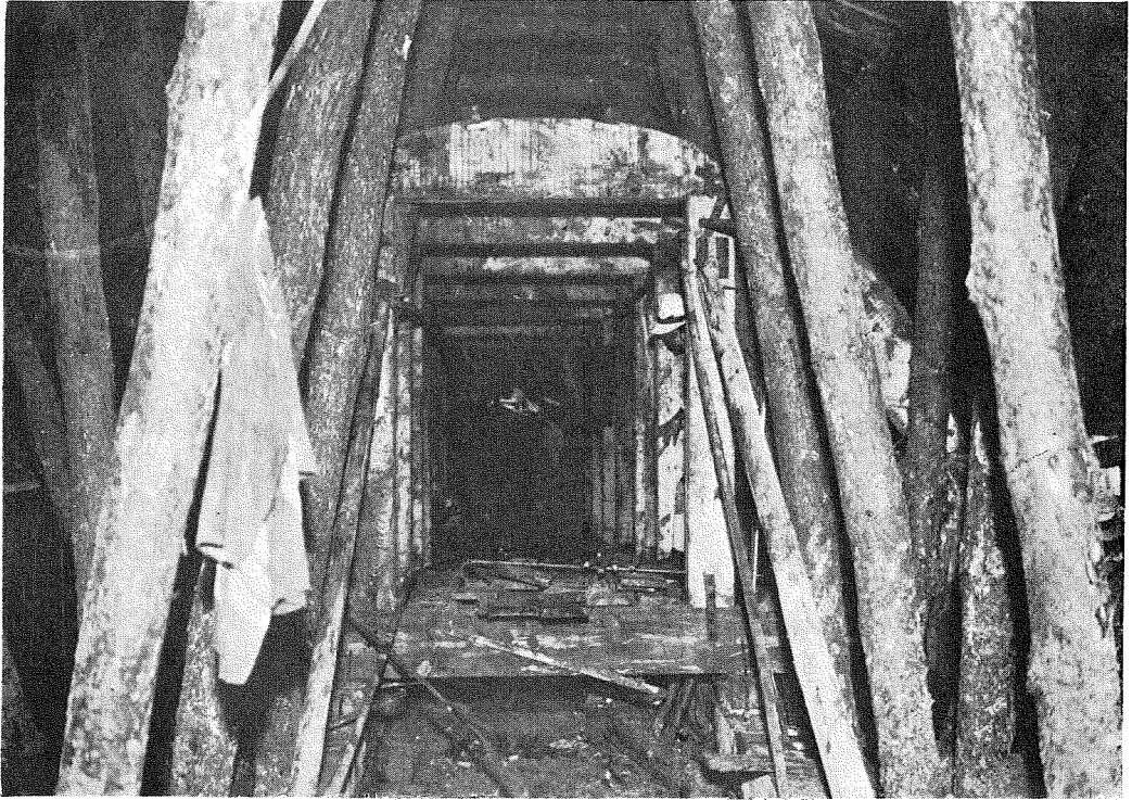
(6) 第一種施工 法による支保工 材及セントル 建組の狀況
