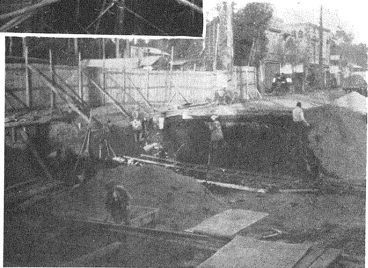
(12) 甲州街道跨線橋根堀 進行中の狀況。
