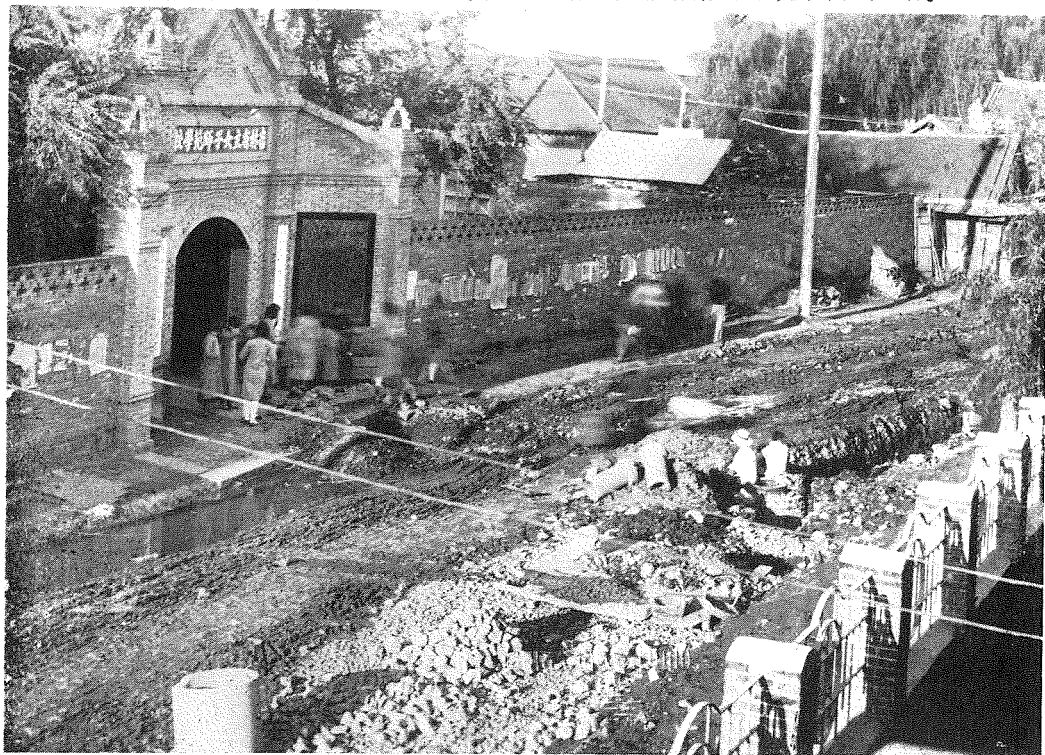
(8) 吉林城内糧米行、吉林省立女子師範學校前下水管布設埋戻作業、大同元年十月十一日。
