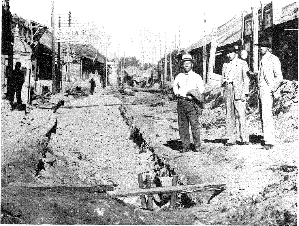
(6) 吉林城内糧米行路面改修並に下水管布設工事、糧米行の内徑65糎モルタル管布設跡埋中で、醉鮮飯店と稱する吉林一流の料亭の前である。左が中川氏、二番目市政課備處土木課長、三番目工事監督員。大同元年九月八日寫。
