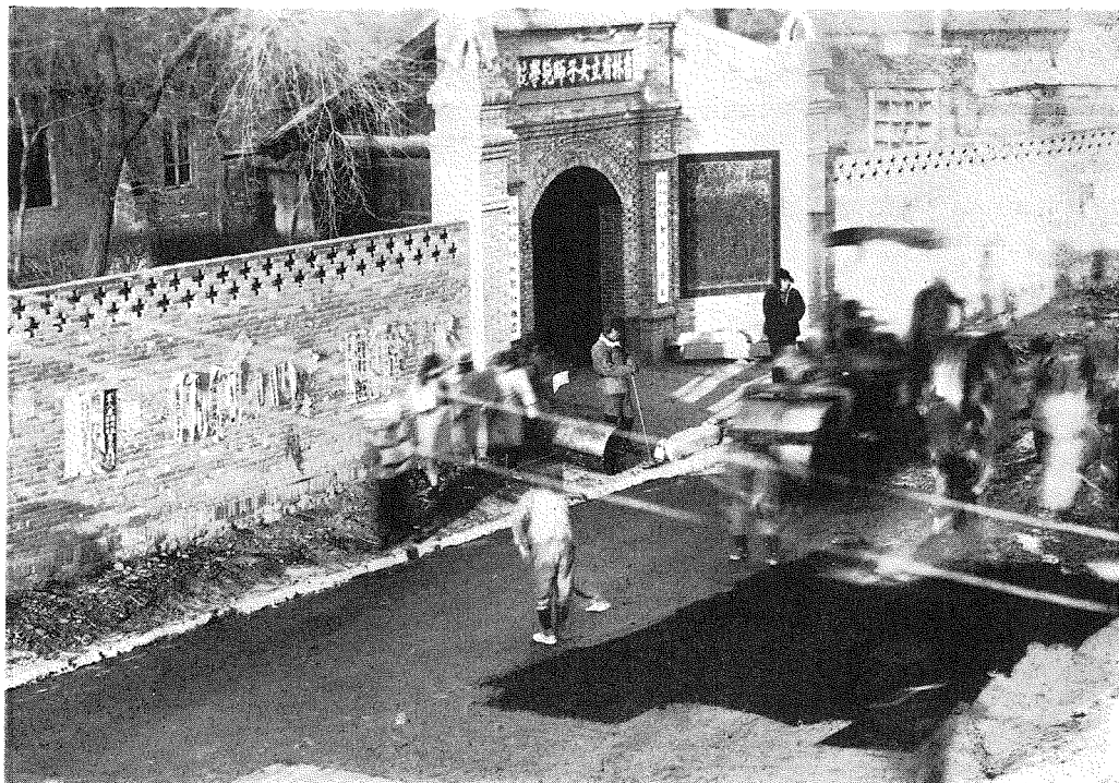
(9) 寫眞8個所のローピット鋪裝作業。大同元年十二月一日。
