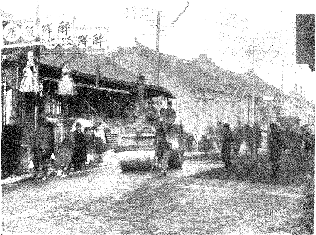
(7) 寫眞6より五十三日を経過した十一月九日の状況、鮮餅飯店前ワープット舗装作業。
