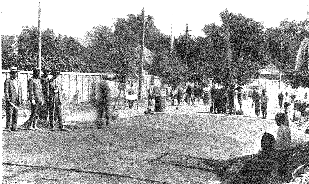
(12) 吉林商埠大馬路改修工事、 日本領事館前コルタール塗布作業 中。
