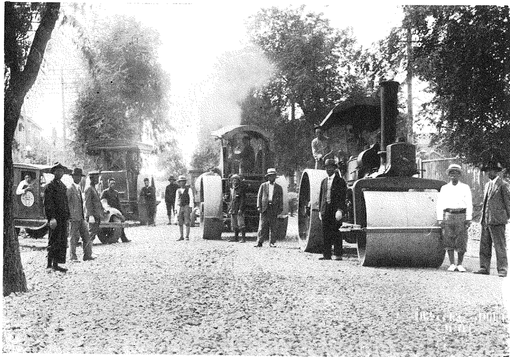
(11) 吉林商埠大馬路舗装工事、 上層砂利輾壓作業中で、18噸及び15 噸のローラーを使用してゐる。
