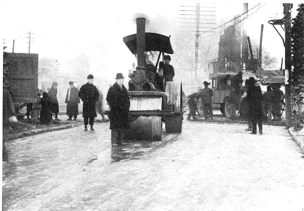
(2) 吉林城内糧米行路面改修並に下水管布設工事の新開門取除き作業及び5種モルタル管布設中、城内より大馬路を望む。
