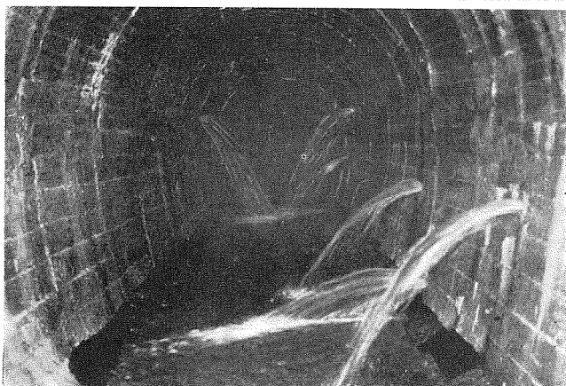
(10) 本水路第一號隧道の湧水、延長 872m 中下口の約 300 米は一般に地質軟弱で、湧水の爲多大の苦難を嘗めた。起點から 550 米附近は湧水量最も多く法線を變更するの餘儀なきにいたつた。
