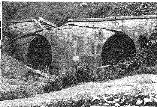
(4) 關西本線龜ノ瀬隧道東口
