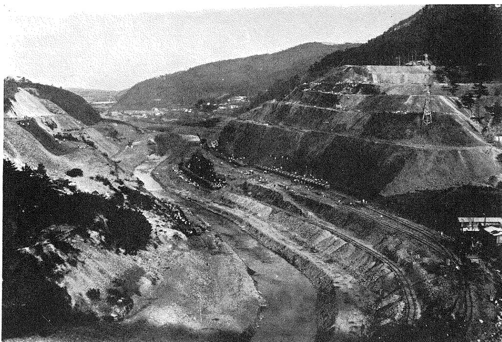
(6) 峡谷の全景、右は明神山切取工事、左は峠切取工事。
