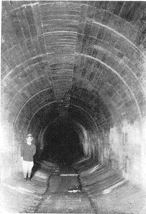
(6) 卷立完了せる水路隧道、Aはモルタルに注入管孔。(12月4日)
