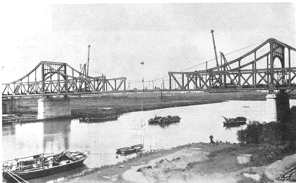
(7) 肱木型構橋中央 Suspended span の架渡し(7月3日) (8) 同上、共に lower chord は鉸 鉸し終る。
