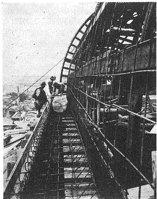
(6) フ - ム 假 柱 据 付。
