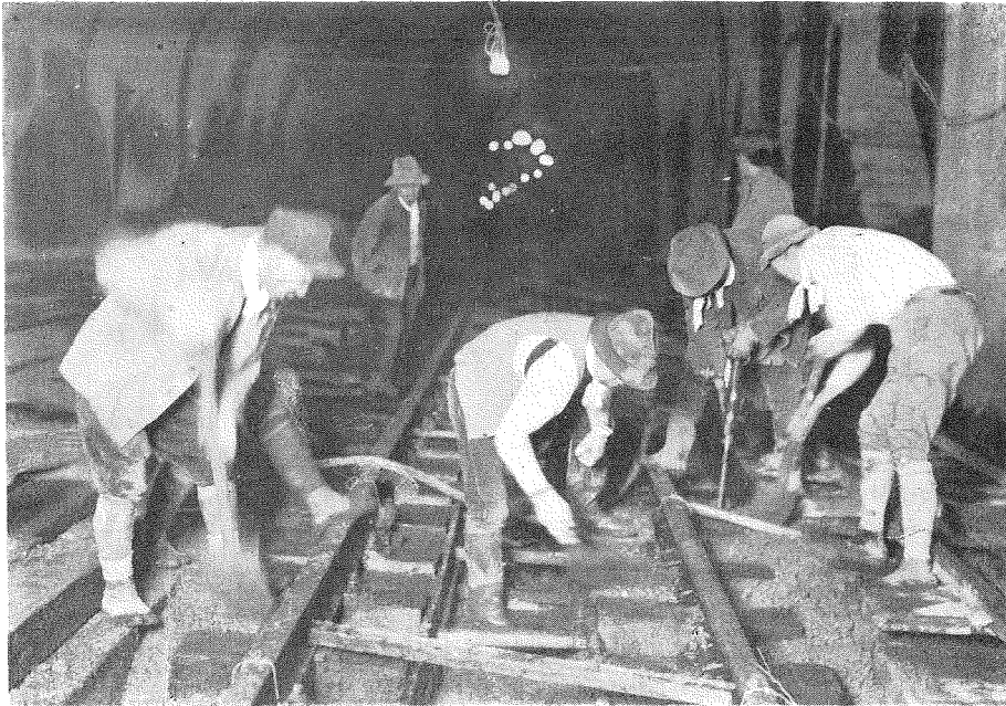
(15) 中 心 混 凝 土 施 工
