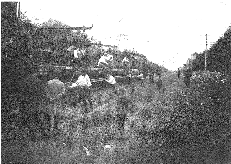
18 函館本線深川妹背牛間に於ける取卸状況。一本卸す毎に24米だけ列車を移動し、小運轉小移動を全然省略して、敷設現場に取卸す。1本1分弱。
