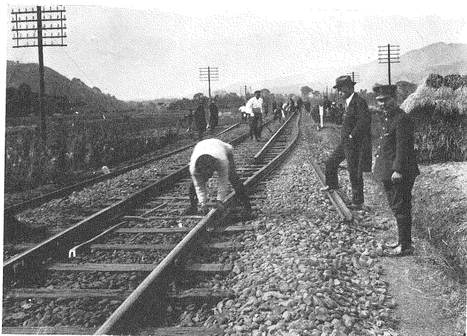
19 軌條更換の實況、片側の軌條から始めて今他の片側の軌條の接目を接続してゐる状況である。
