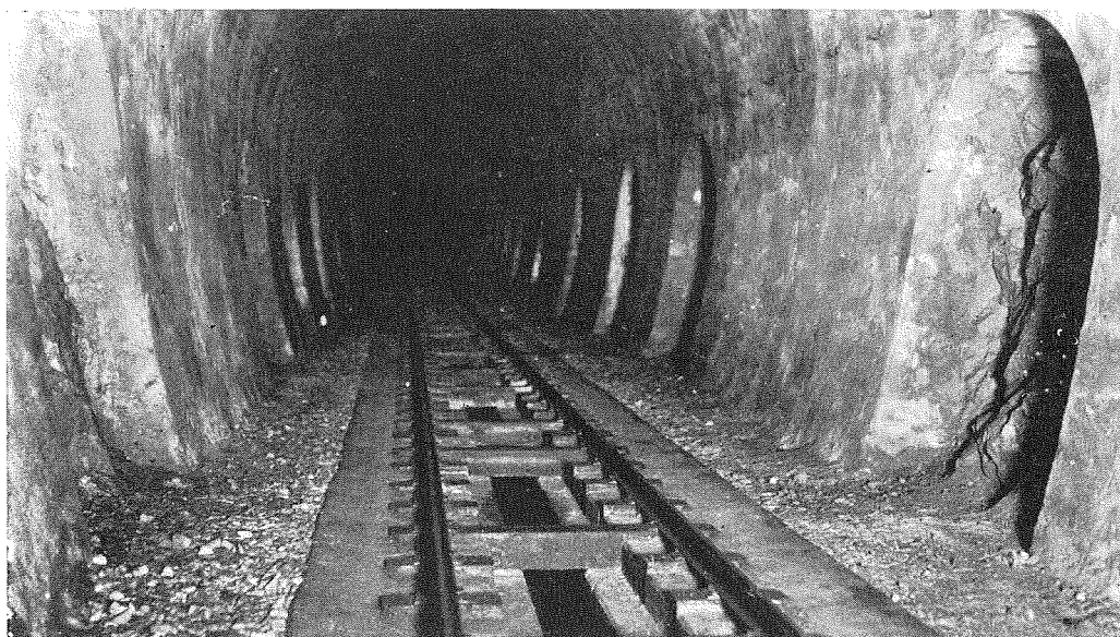
(10) 完成した隧道及道床混凝土。左右側壁のアーチ型は混凝土節約の目的の繰り抜きである。
