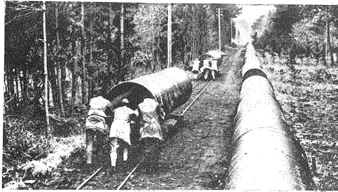
(19) 鋼鐵管の現場配列。
