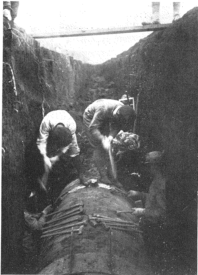
(20) 鋼鐵管鉛接合工事。
