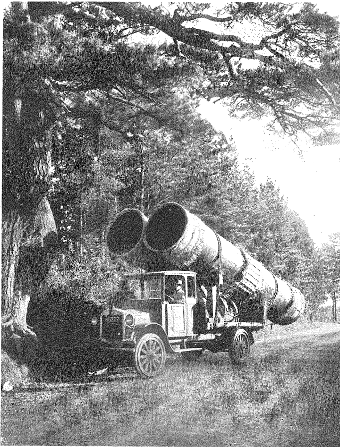
(18) 鋼鐵管の運搬 (内徑1,100耗、長6,000耗、管厚10耗 重量1,700)
