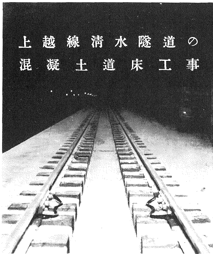
(1) 完成した道床混凝土
