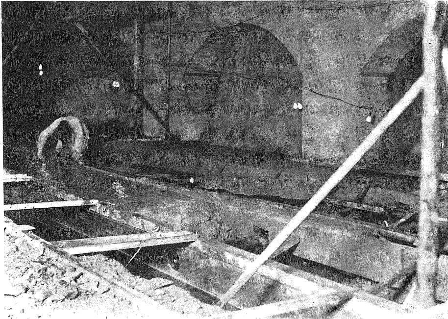
(2) 兩側 混 凝 土 幕 板 及 排 水 鐵 管 取 付
