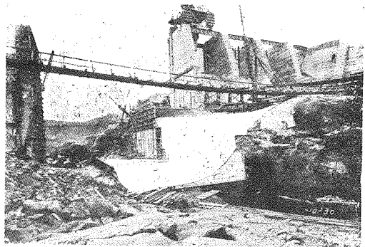
第 20 圖 舊河床に於ける堰堤工事。
