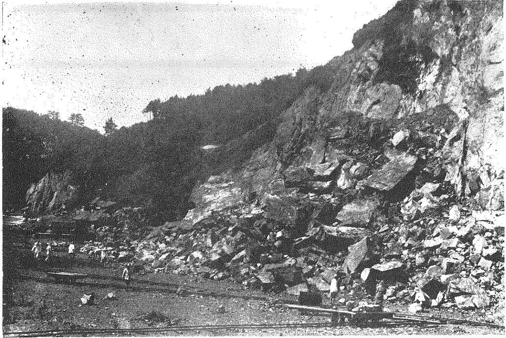
(1) 白野江採石場 空洞式大爆破による岩石崩壊状況 (昭和七年五月二十八日下關要塞司令部検査済)
