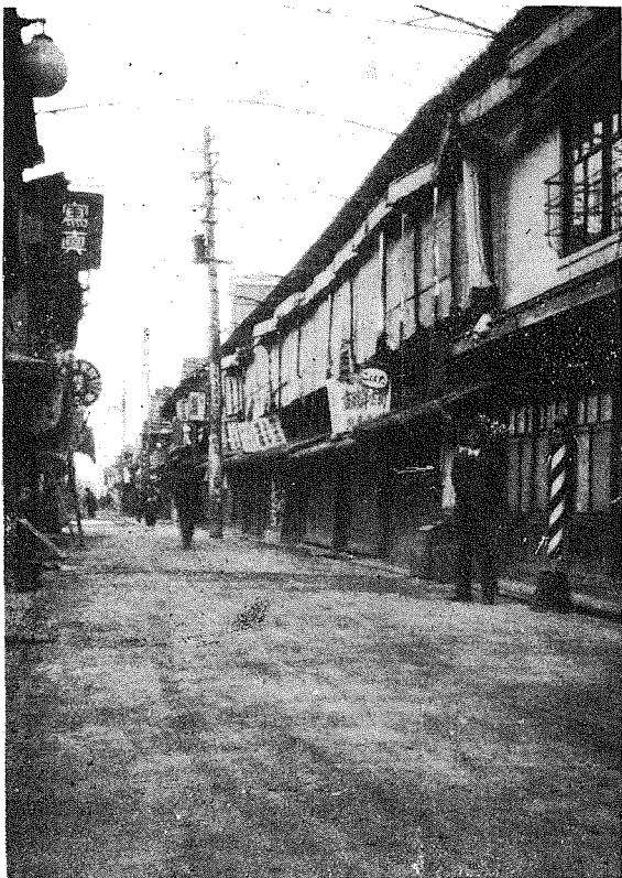
姫路市元町通り膠石鋪裝道路
