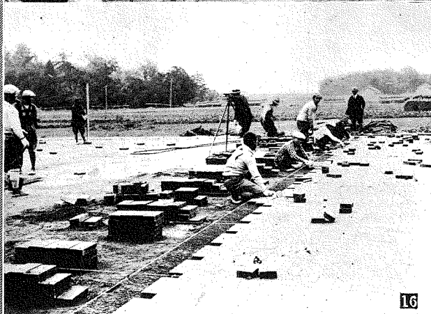
16 國道本線と幅員21.0 mの支道交叉點附近表 層角網代張り施工實況
