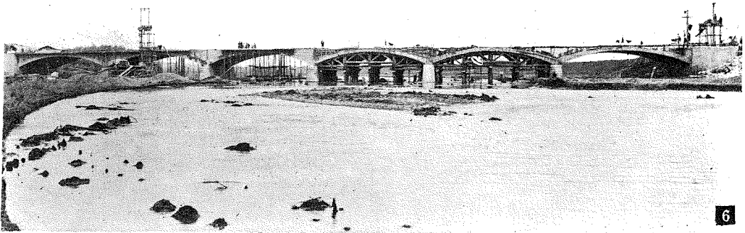
6 工事中の烏羽大橋
