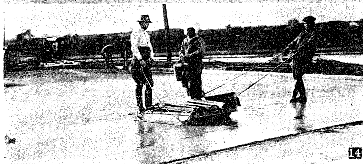
15 アスファルト舗裝 基礎混凝土打及び4 輪ローラーにて輾壓 の實況
