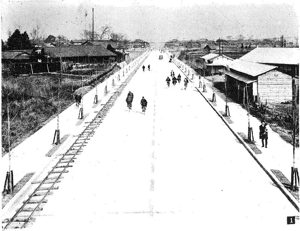
1 竣功せる京阪國道の一部(淀町地内)
