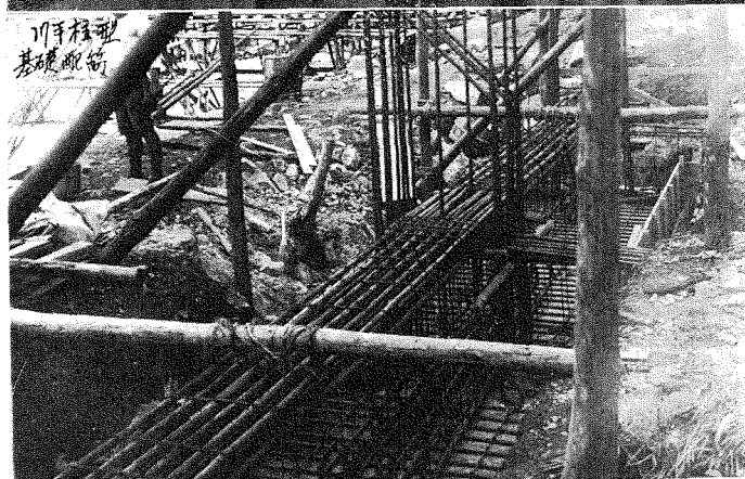
8. 川手柱型基礎配筋
