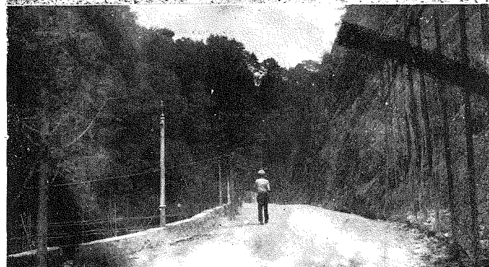
3. 洞門築造前の落石防護工
