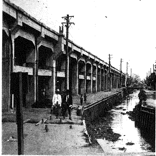
(5) 隅田川貨物線から三河島 方面を望む。二柱式鐵筋 混凝土高架橋。
