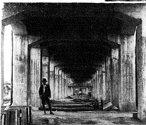
(3) 橋梁部分のブラケット式電車線用鐵塔。
