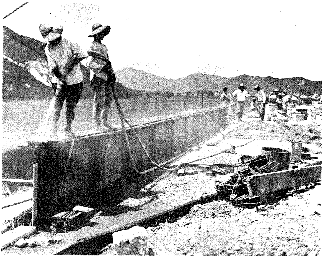
3 主桁にセメントモルタル吹付作業中
