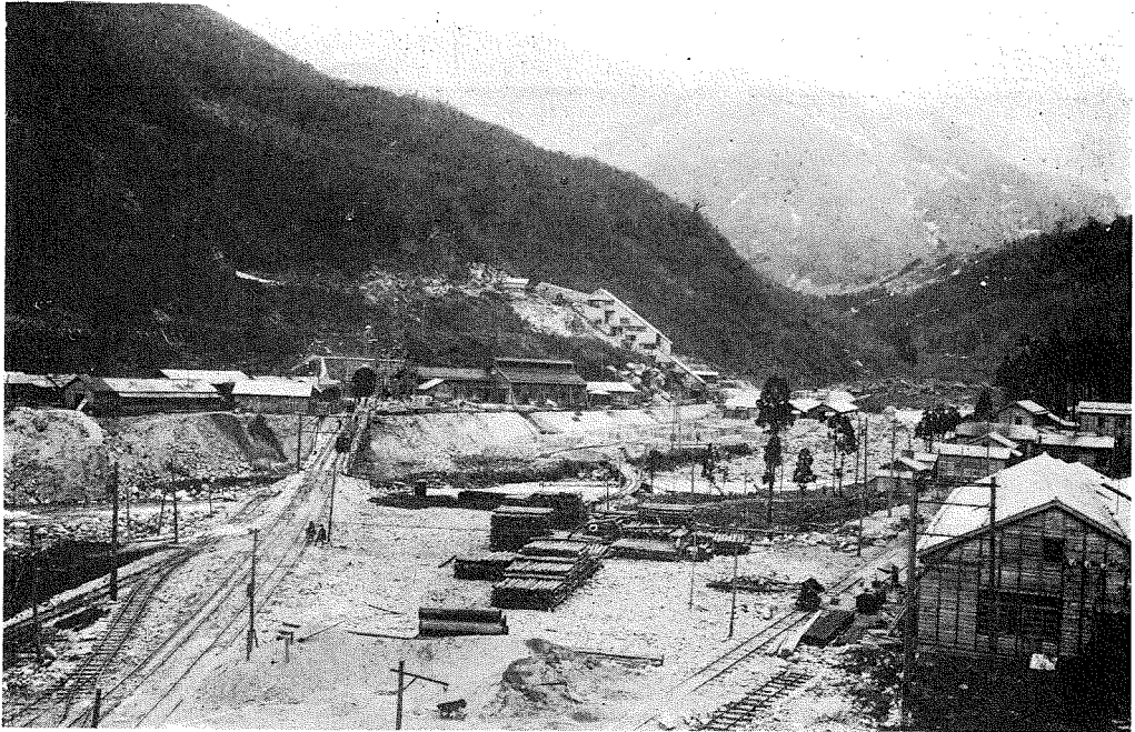
(10) 清水隧道長岡口全景、正面がトンネル坑口 その後方に雪を頂くのが茂倉岳である。
