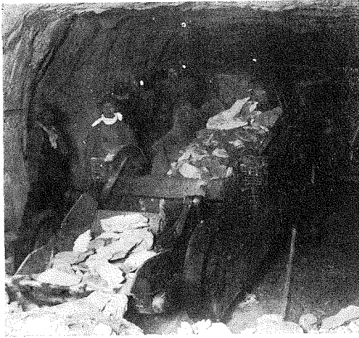
(13) マイヤース・ホウレン 一備積機、備は絶へずバケツ トでベルトコンベヤーにかき 上げられ寫眞15に見る如く後 方に送られて土運車に積ま れる。
