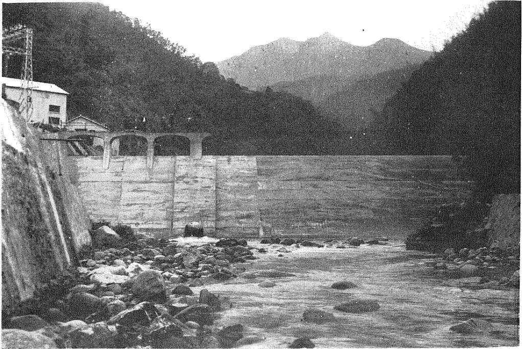
(11) 逆調整池堰堰を下流より見る
