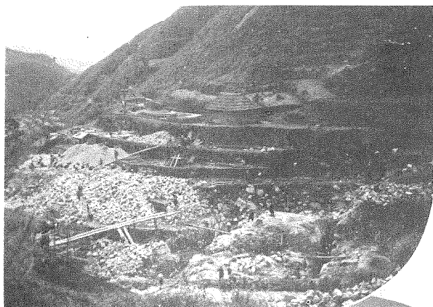
← (1) 調整池堰堤基礎掘鑿。
