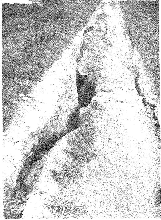
(左)上利根左岸新會村高島地先に於ける堤防馬踏の龜裂陷沒。(右)同右岸明戸村石塚地先。龜裂は堤防の縦の方向に多い。
