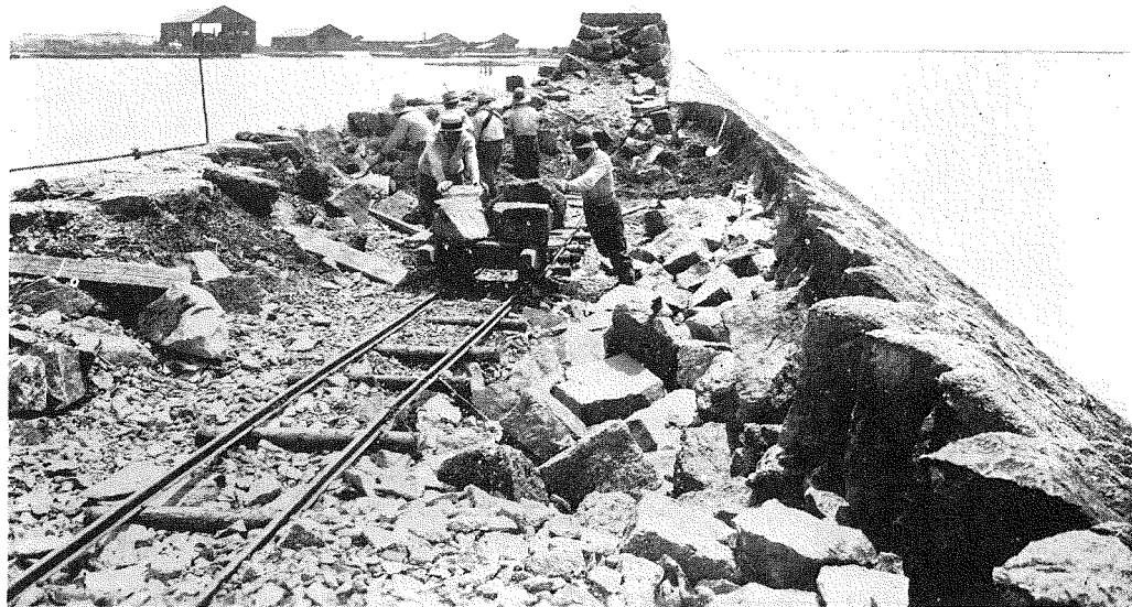
1 木津川尻防波堤取 除工事。(5,6)
