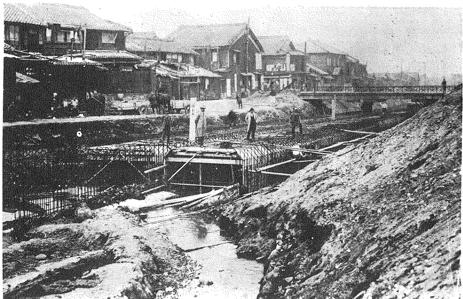
第二圖 暗渠工事中の生田川。國道線と交叉附近より 下流を望む。
