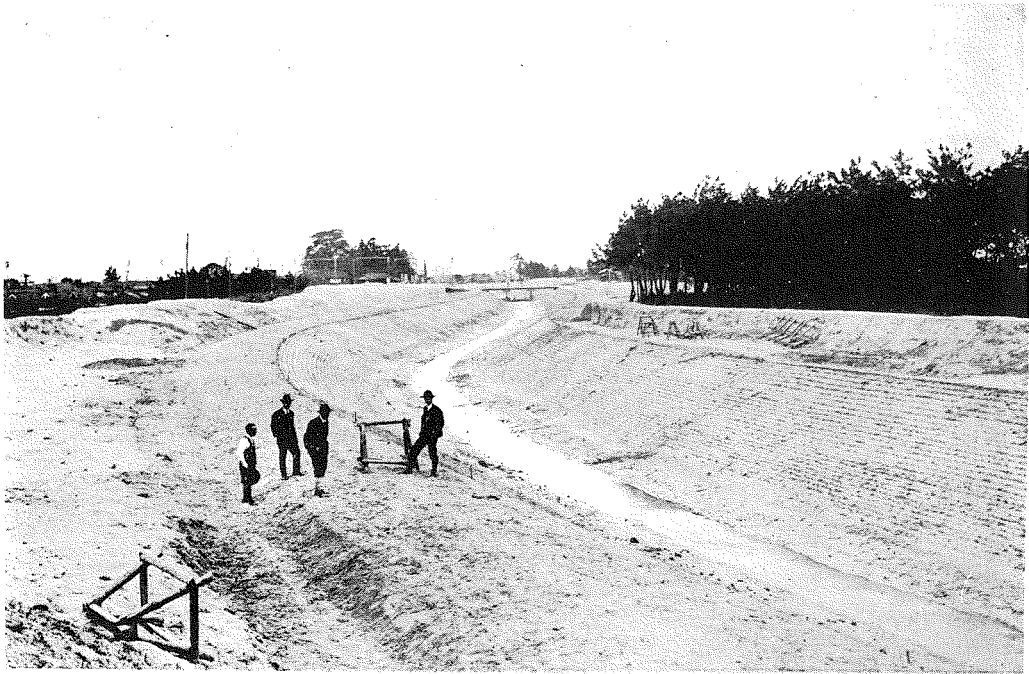
(2) 寢屋川改修 工事築堤(外島 橋上流)
