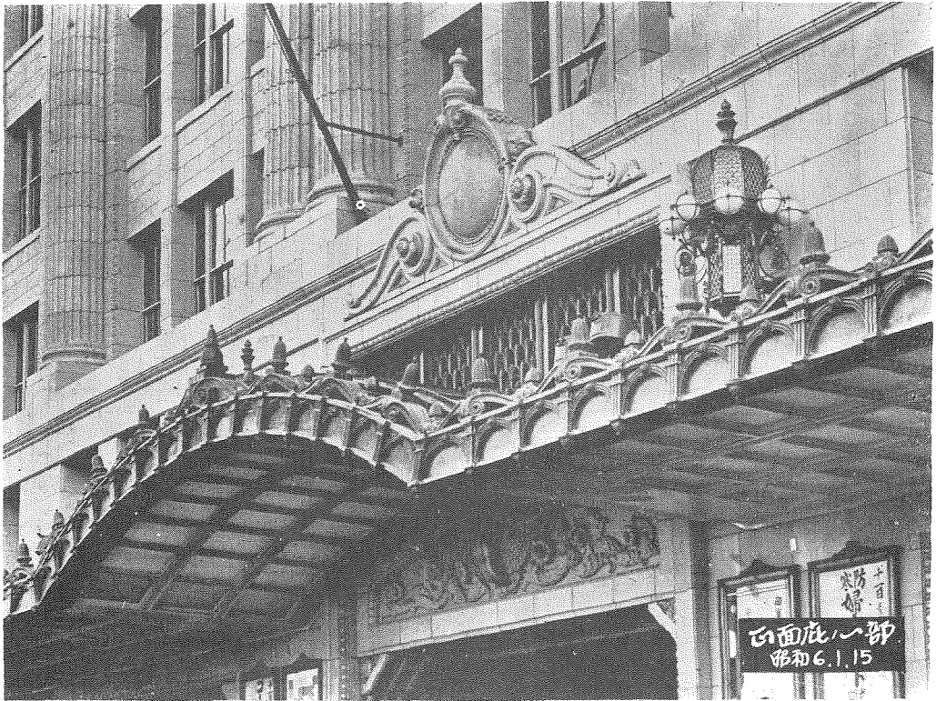
(3) 南海ビル正面入口庇の一部。
