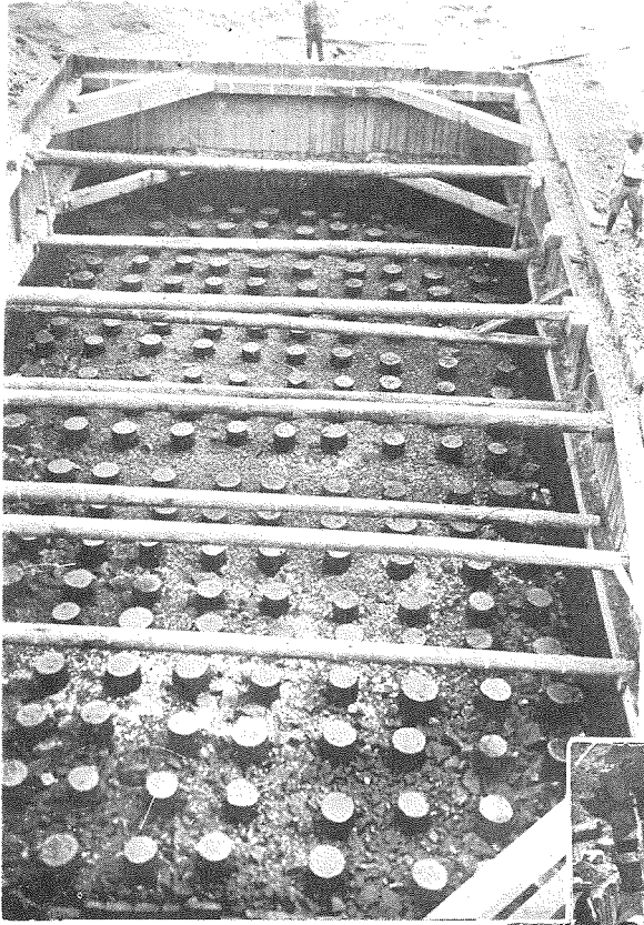
1 橋脚床固作業業石填充を終りたるもの。
