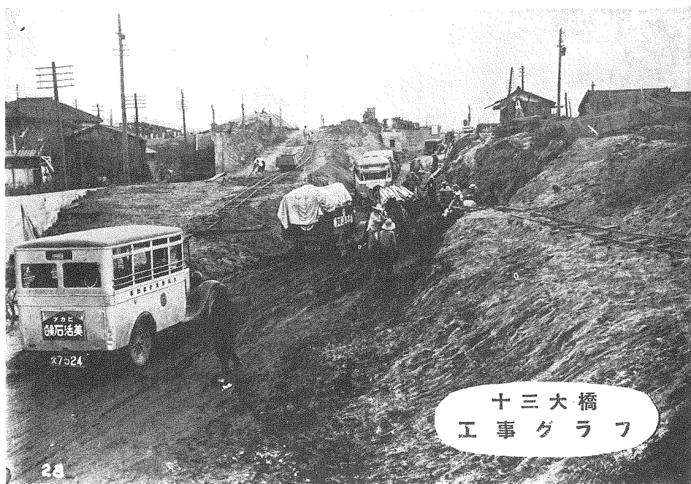
9 十三橋北詰に於ける道路切替準備。
