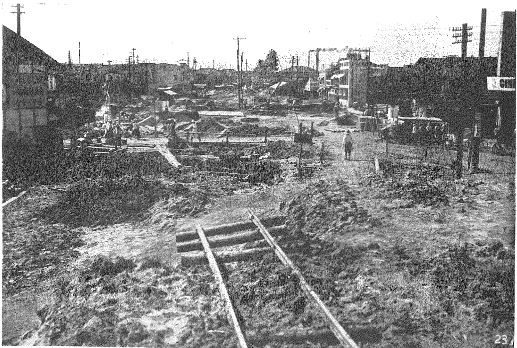
(3) 舊伊丹線より上堀橋及本町通りの遠望。
