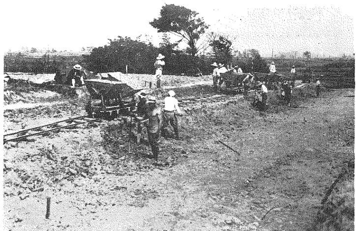
6 同上、明石郡大久 保村大字大窪字大 畑、土勾配切取の 實況。(6.6)
