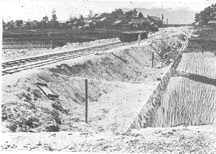
3 國道第2號線工事 廣島縣佐伯郡觀音 村五日市町地内路 床工事作業中の景 (6.7.7)
