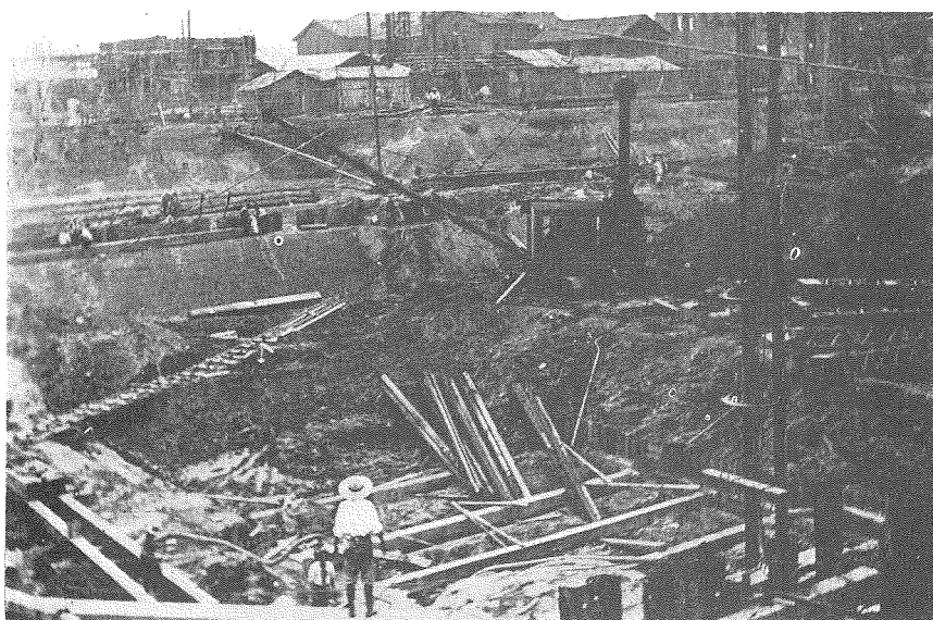
(2) 梅田現場 東南より見たる掘鑿及び切張入れ (5.7.19)
