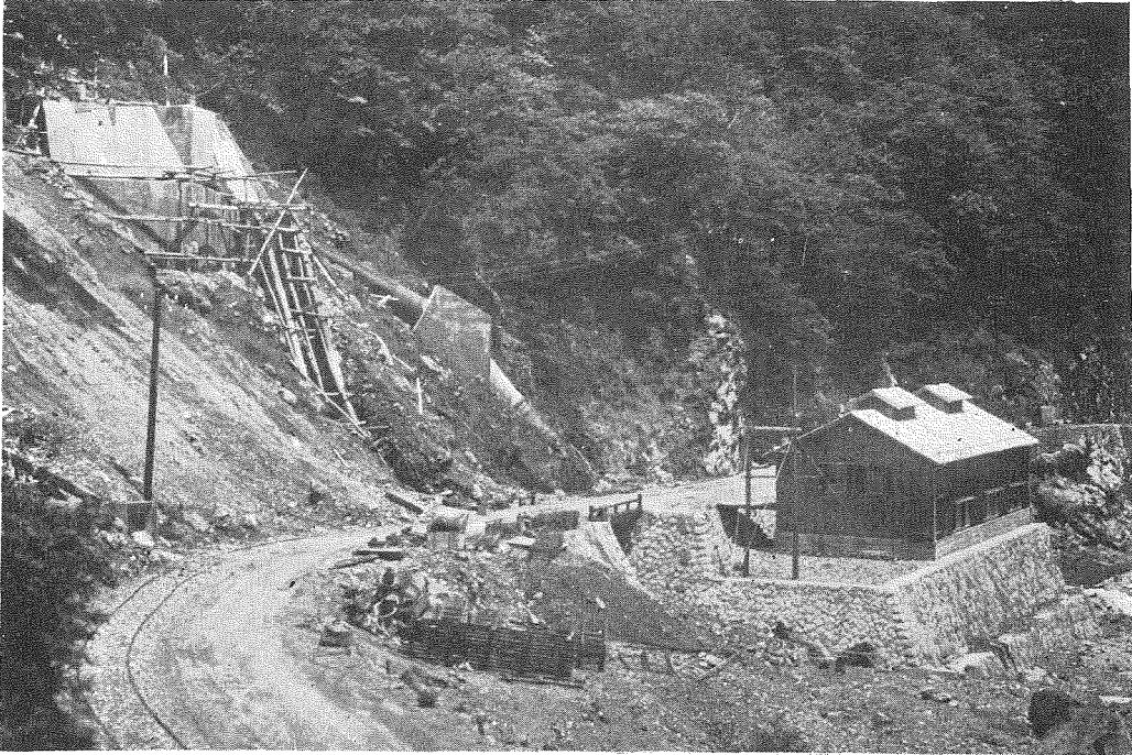
1. 鬼怒川改修五十里(イカリ)調整池堰堤工事用發電所、 上流左岸より見る、(拔和六年七月中旬現狀)
