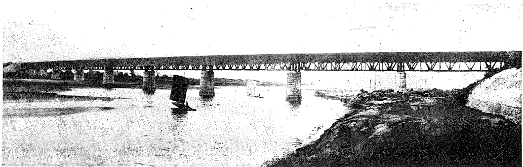
曾文溪橋全景。橋長1,119尺、徑間長120呎九連。
