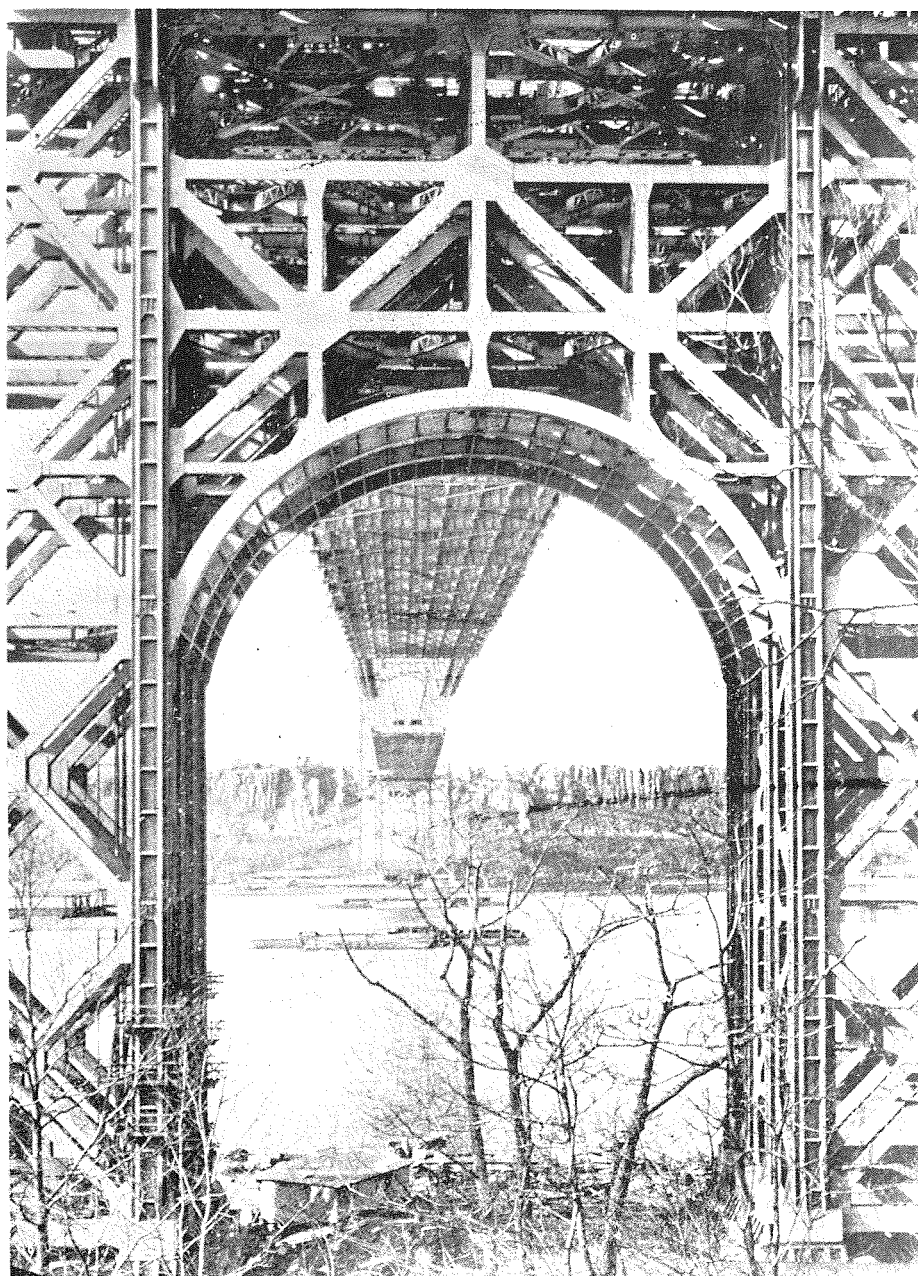
紐育側橋塔より見たる橋床の鐵骨作業、1930年12月13日の工事狀況、約60%竣工せる處である。
