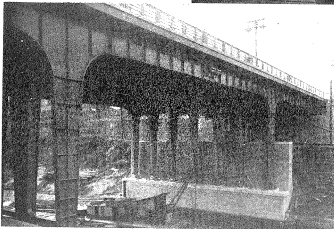
(9) 完成せる橋梁の側面仰觀。
